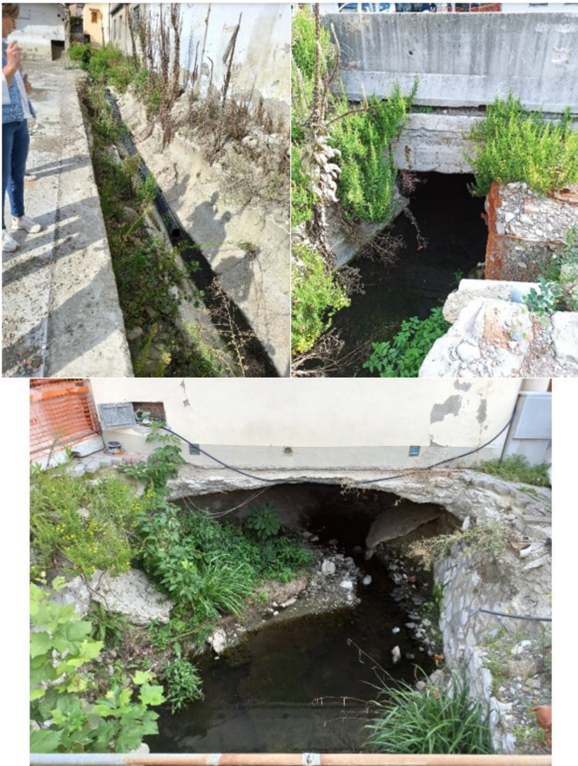
Figura 5. Stato di fatto del Fosso Trescellere nell'area della nuova Piazza "Arte della Lana": tratto a cielo aperto (in alto a sinistra); attraversamento provvisorio sotto via Fratelli Rosselli (in alto a destra); attraversamento sotto l'edificio della Misericordia (in basso)
