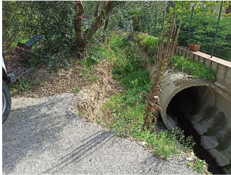
Figura 2.8. Tratto compreso tra l'uscita dalla Misericordia e lo scolmatore situato nei pressi di Via Vincenzo Nuti, sopralluoghi tra settembre e ottobre 2025
