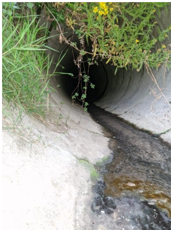
Figura 2.4. Sbocco del fosso tombato nell'area ex Dainelli, sopralluoghi tra settembre e ottobre 2025
