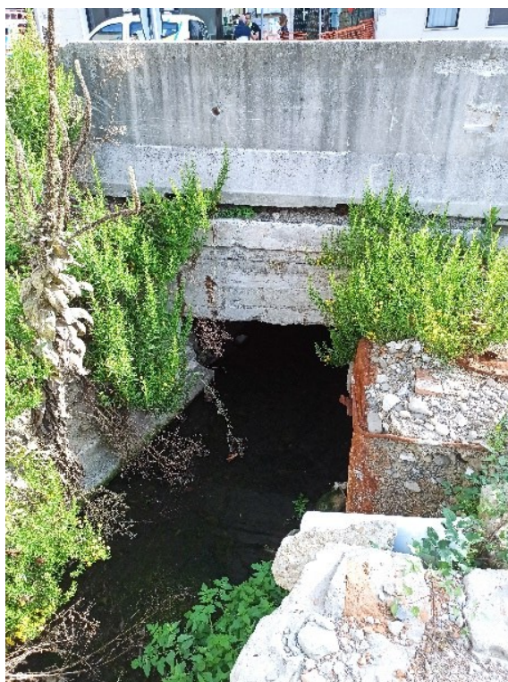
Figura 2.6. Passaggio sotto strada di Via Fratelli Rosselli, sopralluoghi tra settembre e ottobre 2025
